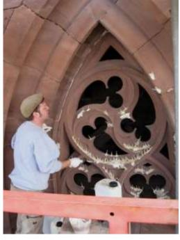
Kanülen angebracht, und die Risse werden mit Latex verschlossen. Der Latex kann nach dem Aushärten des Harzes wieder spurlos entfernt werden.
