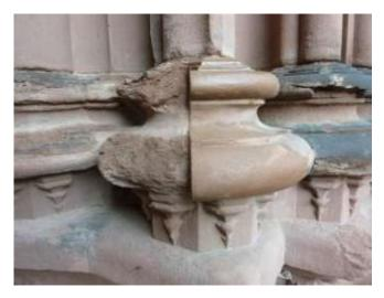
Fehlstellen können mit verschiedensten Mörteln aufgebaut werden. Auch hier muss das Material jeweils den Bedürfnissen der Originalsubstanz angepasst werden. Auch die Grösse und Art der Aufmodellierung sind bei der Mörtelwahl zu berücksichtigen. Grundsätzlich wird zwischen mineralischen und Kunststoffvergüteten Mörteln unterschieden. Oft stelle ich die Sandmischungen mit gewünschter Farbe und Kornmischung selbst her.
