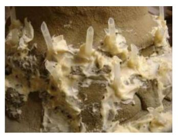
Risse und Hohlstellen müssen gefüllt werden, damit sie kein Wasser mehr aufnehmen können, was zu weiteren Schäden führen kann. Hintergossen wird meist mit Kunstharz. Damit das Harz injektiert werden kann, werden
