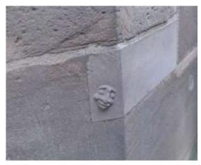
Eine weitere Möglichkeit der Restaurierung Ist der teilweise Steinersatz, mit Vierungen. Dafür wird die schadhafte Stelle ausgehauen und ein Stück Stein wird eingepasst und überarbeitet. Im Idealfall sind die Fugen praktisch unsichtbar.
