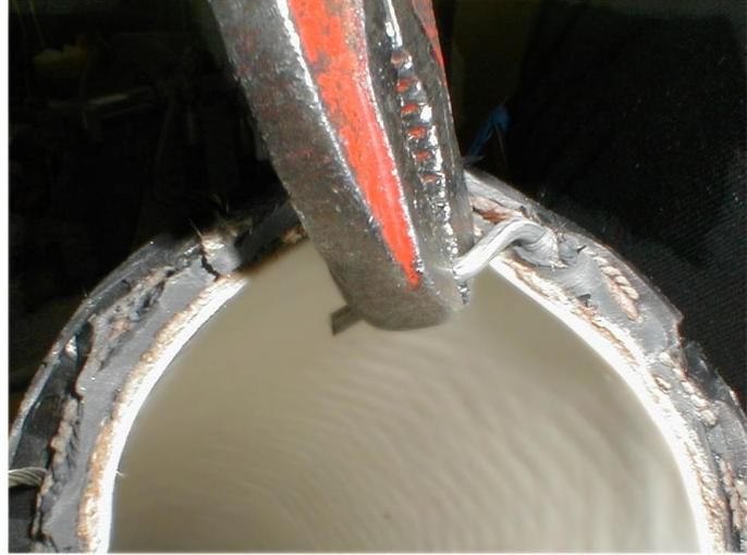
Mit einer Rohrzanze die Stahlwendel nach innen biegen. Das spitze Ende der Wendel fest in die Schlauchseele ...
